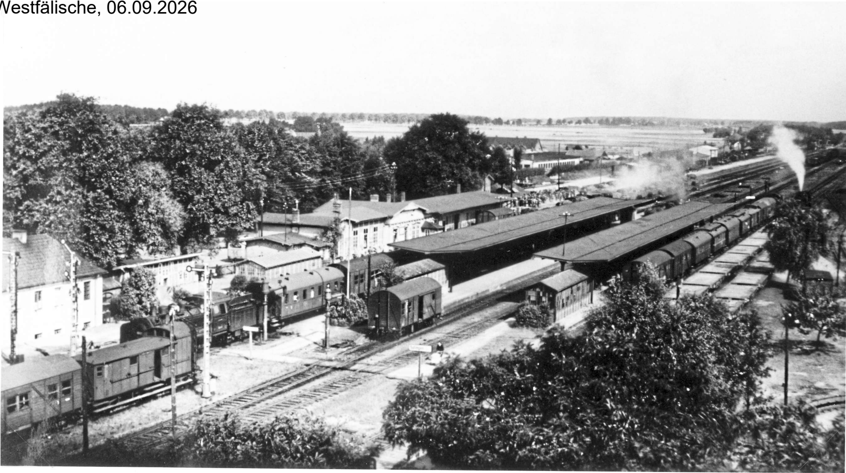
Im Bahnhof Sulingen trafen sich die Züge aus und nach Bremen, Diepholz, Nienburg und Rahden.
