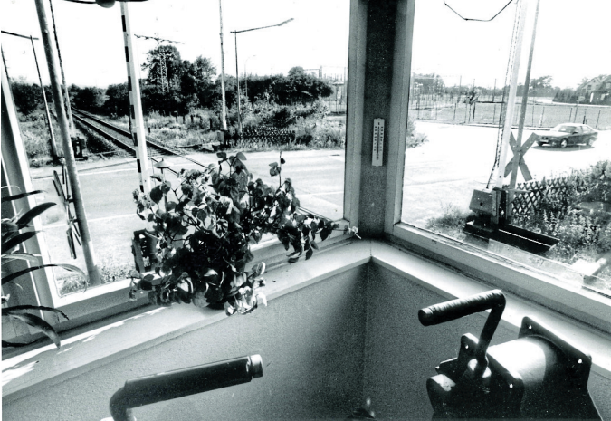
Vom Stellwerk Rahden-Süd hatte der Posten den Bahnübergang Mindener Straße im Blick. Im Vordergrund sind auf diesem Foto aus den 1990er Jahren die Griffe der Kurbeln zu sehen, mit denen die Schranken geschlossen und wieder geöffnet wurden. Das Stellwerk wurde vor vielen Jahren abgerissen.
