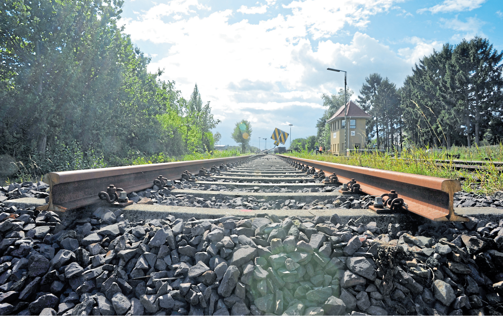
Im Bahnhof Sulingen laufen derzeit umfangreiche Gleisbauarbeiten. Nach dem Ausbau einer Weiche ist das durchgehende Streckengleis Rahden-Bassum aktuell am Nordkopf des Bahnhofes unterbrochen. Foto: Joern Spreen-Ledebur
